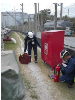
รูปที่ 10 การตรวจสอบอุปกรณ์ระงับเหตุฉุกเฉิน
